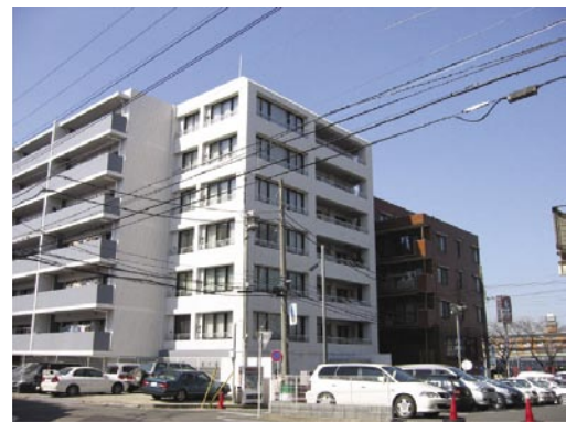
図3 日照を遮られた集合住宅。後ろの 5 階建て店舗併用の集合住宅は、新築された 7 階建ての集合住宅によって日陰になっている。両者の壁面のあいだには、1.5m と 3.0m の計 4.5m 幅の空き地があるが、日照の助けにはならない（2 月末正午ごろに撮影）。
