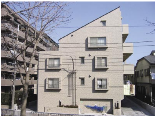
図5 歪んだ集合住宅。東西に細長い敷地に建った集合住宅の屋根が勾配0.6で北側に傾斜し、1階は駐車場にして高さを抑えている。
