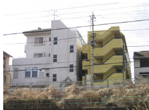
図4 日照ばかりか採光もわるい集合住宅。外階段のある右側のビルの 2～4 階が集合住宅になっているが、南東側のビルに接近しているために、4 階を除いて日照がない。
