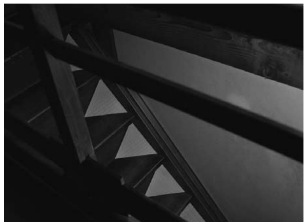
【写真11】 階段の隅っこ (階段の上部から)
