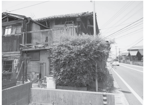
写真13 半壊の空き家は国道に面している
