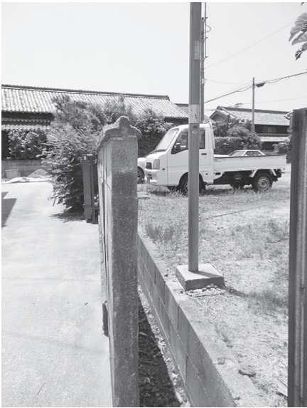
写真12 後ろ側に支えの無いブロック塀の左は子どもたちの通学路
