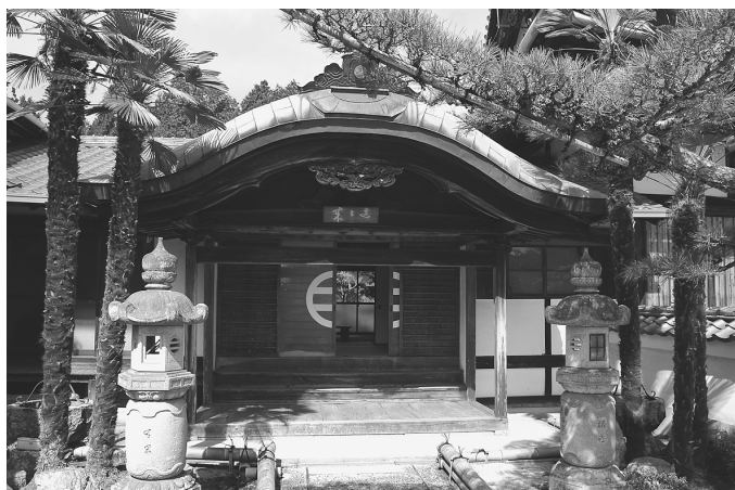
3. 愚溪寺庫裡・方丈（建替前）
