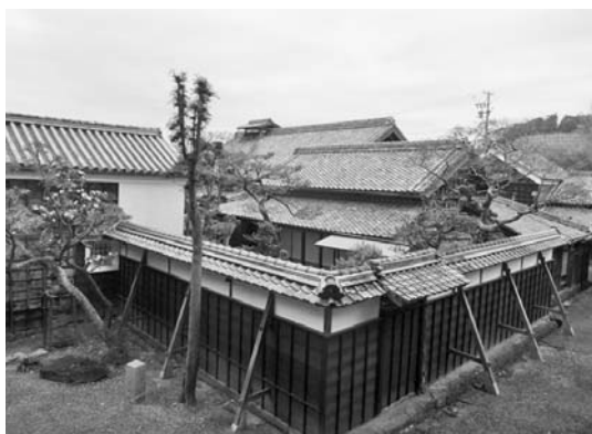
図5 修復された佐七家の座敷、座敷南庭門塀
